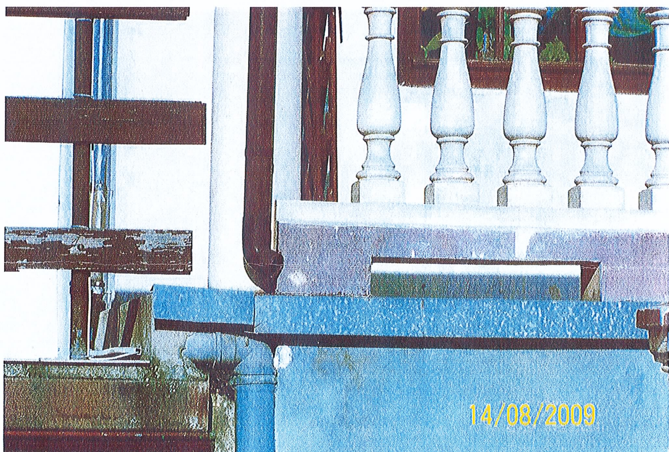
Rynna spustowa wypuszczona na chodnik
