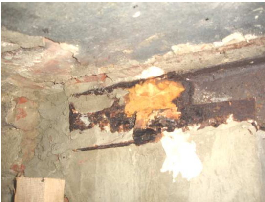
NADPROŻA STALOWE NAD OTWORAMI DRZWIOWYMI – STAN ZŁY.
