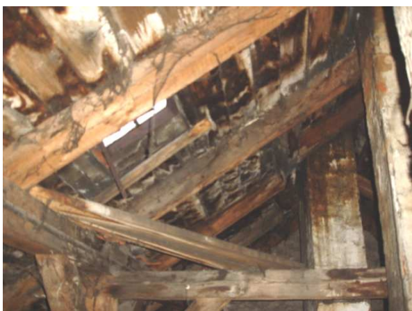
WIDOK NA STAN KROKWI I POSZYCIA DACHU
