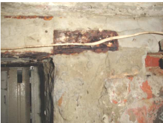
NADPROŻA STALOWE NAD OTWORAMI DRZWIOWYMI I OKIENNYMI – STAN ZŁY.
