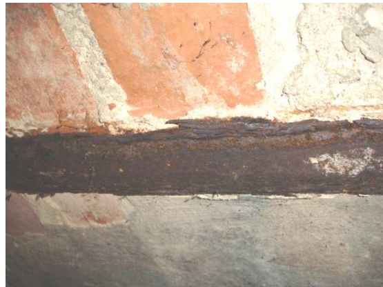
POSTAĆ BELEK STALOWYCH W STROPIE KLEINA – STAN ZŁY.
