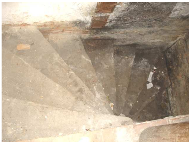
WIDOK NA SCHODY PIWNICZNE MUROWANE NA KLATCE SCHODOWEJ „A”.
