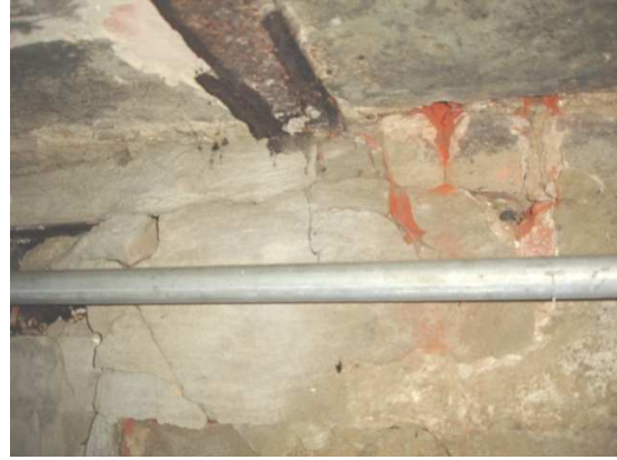
WIDOK NA BELKI STALOWE W STROPIE KLEINA – STAN ZŁY.
