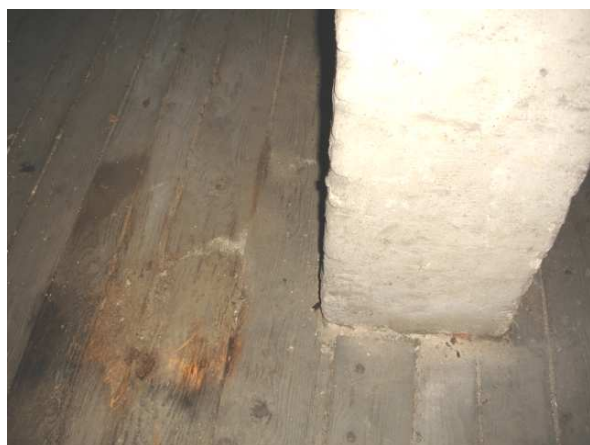
LICZNE UBYTKI NA STRYCHU W PODŁODZE Z DESEK.
