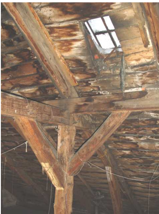
KONSTRUKCJA DACHU – POŁĄCZENIE SŁUPA, BELEK POZIOMYCH, MIECZY I KROKWI.
