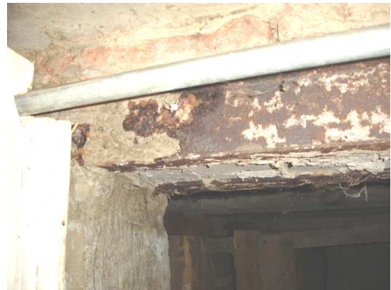
NADPROŻA STALOWE NAD OTWORAMI DRZWIOWYMI – STAN ZŁY.
