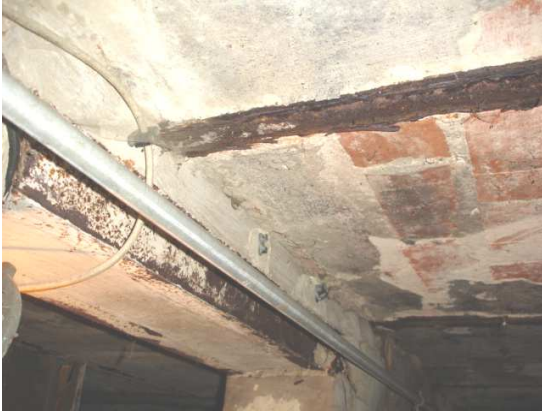
WIDOK NA BELKI STALOWE W STROPIE KLEINA – STAN ZŁY.
