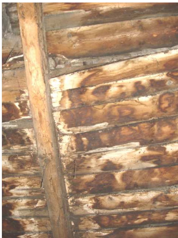
ORAZ NA STAN KROKWI I POSZYCIA DACHU.
