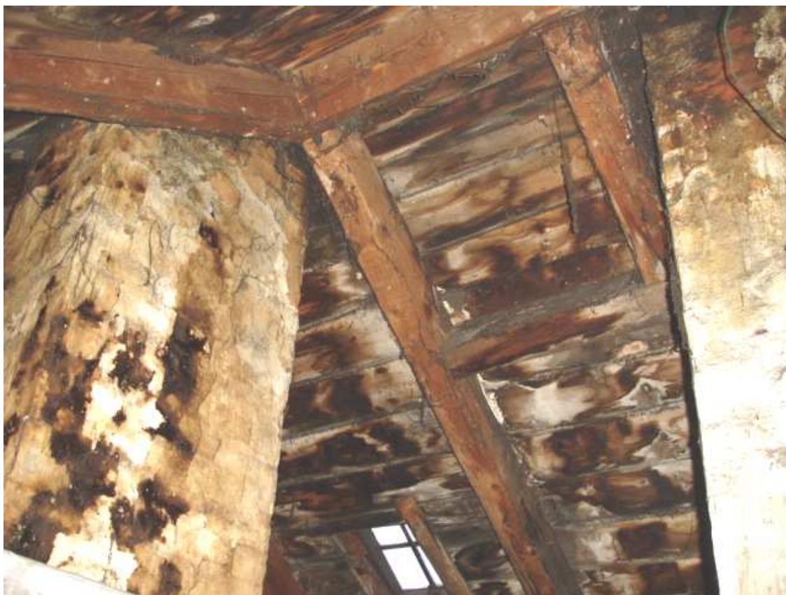
WIDOK NA BELKĘ KALENICOWĄ, KROKWIE I POSZYCIE DACHU ORAZ NA KOMINY.
