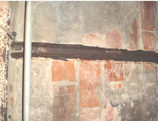
POSTAĆ BELEK STALOWYCH W STROPIE KLEINA – STAN ZŁY.
