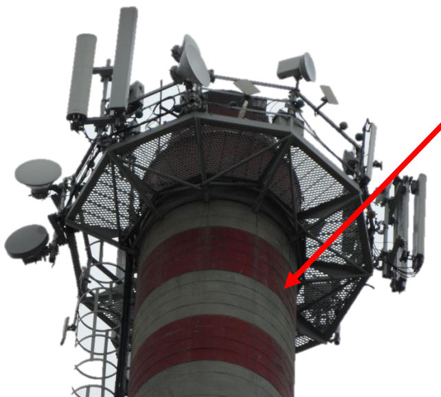
Rysunek nr 5.32 Poziom instalacji anten stacji bazowej BSU1 i radiolinii
