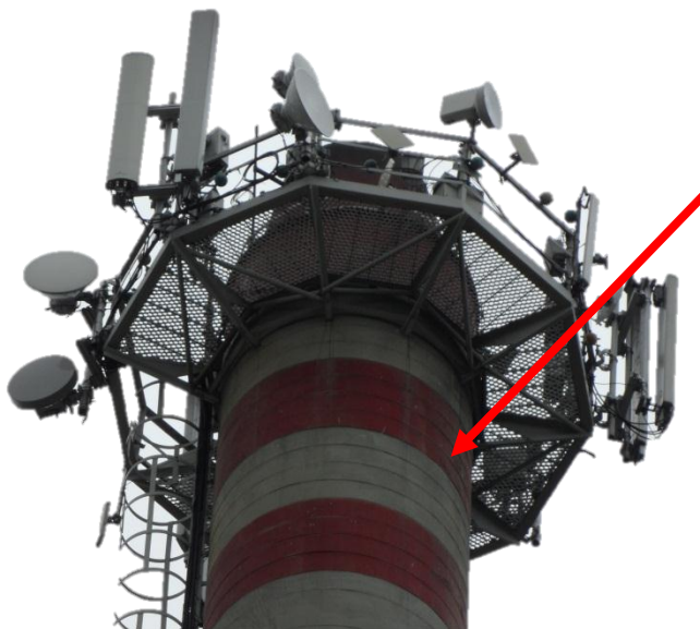
Rysunek nr 5.2 Poziom instalacji anten stacji bazowej BSU1 i radiolinii
