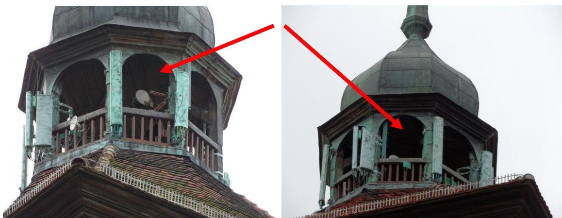
Rysunek nr 5.35 Miejsca lokalizacji anten sektorowych stacji bazowej BSU2
