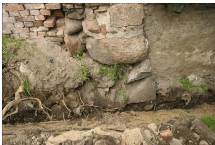
Wkop pod kabel zasilający na wysokości reliktyw murów miejskich. (fot D. Wyczółkowski)
