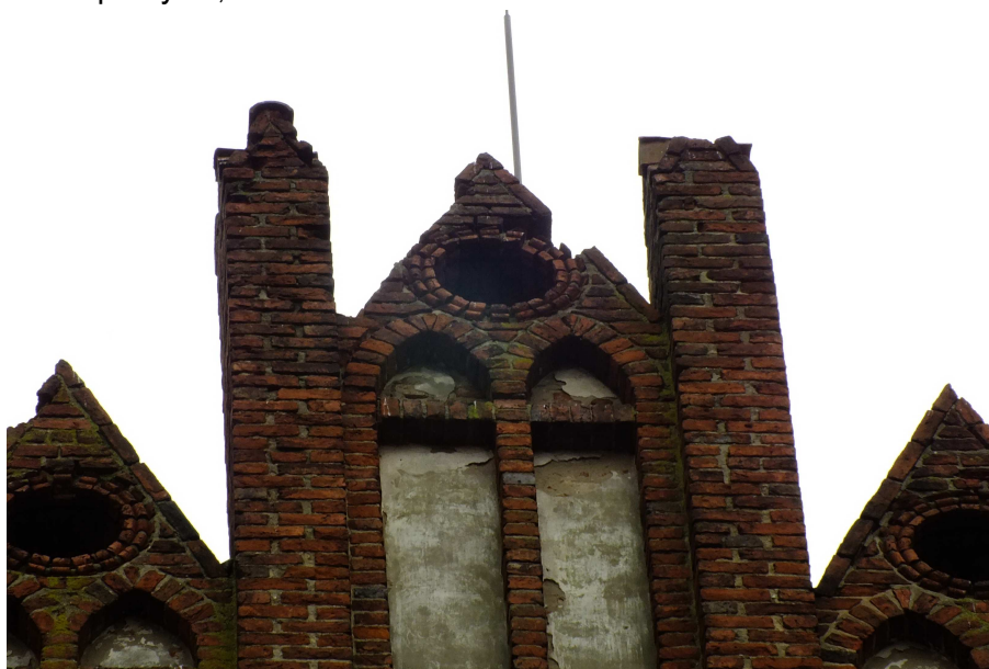
Fot.1 Widoczne znaczne ubytki cegieł w szczycie i sterczynach szczytu pd.-zach.
